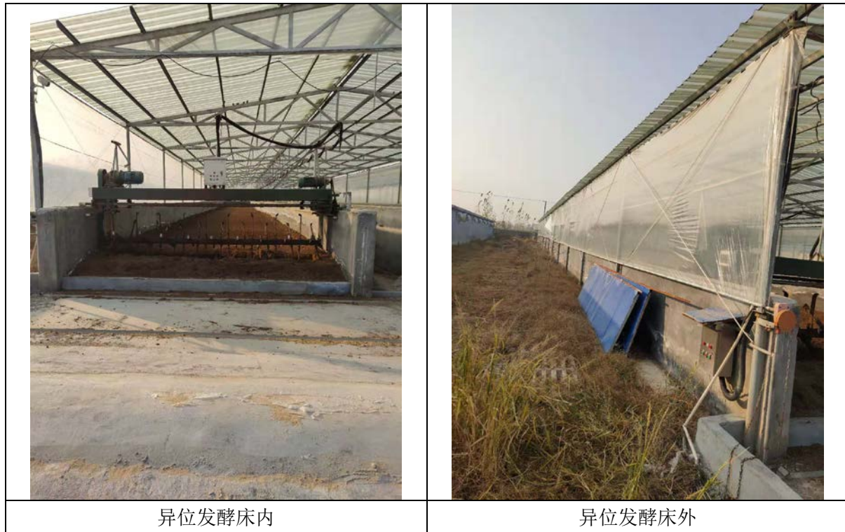
图3.5-4 粪污处理系统建设情况图
