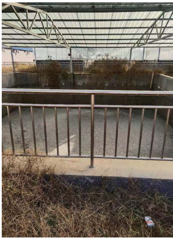
集粪池封闭建设
