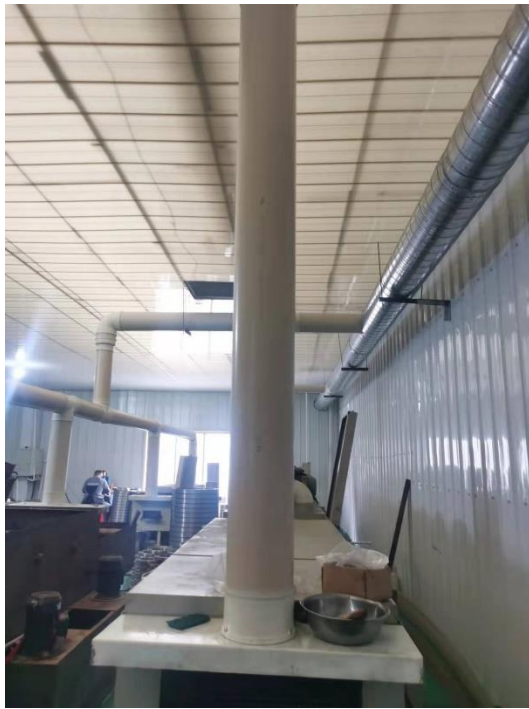
清洗机集气管线
