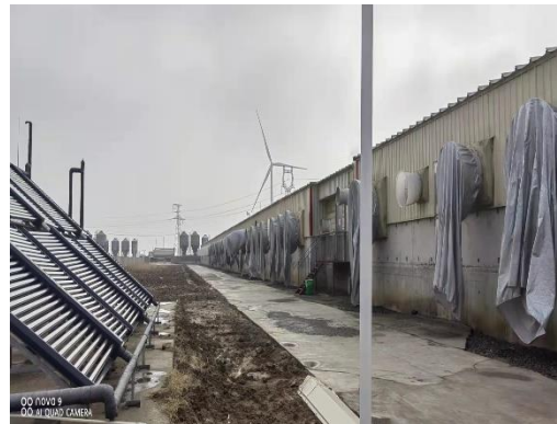
配怀舍外部照片
