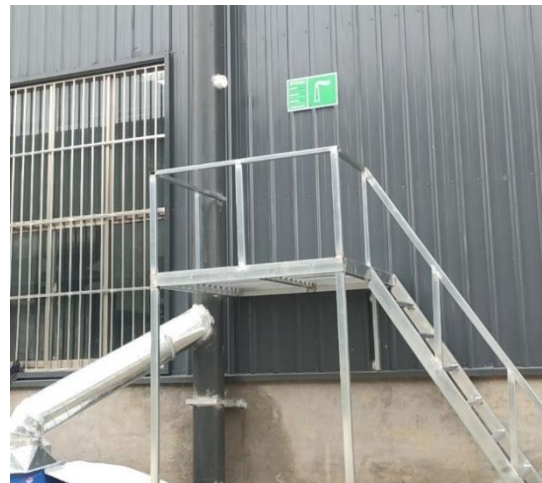
DA002 废气采样平台
